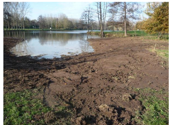
Des berges de l'étang de Barjouville ont été reprofilées en 2011, en pente douce en vue de permettre aux ceintures végétales de se développer. (© Cen Centre-Val de Loire// M. Houessè)
