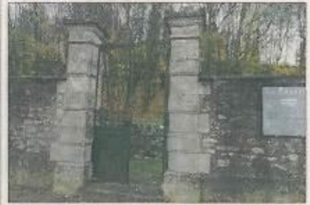
Les murs d'enceinte seront préservés.
