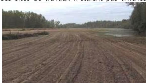
Chenal de Vauvrette après hersage des sables NP-CENB
