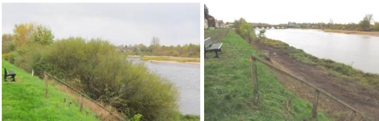
La première partie des quais Foch avant et après les travaux – BF-CENB
